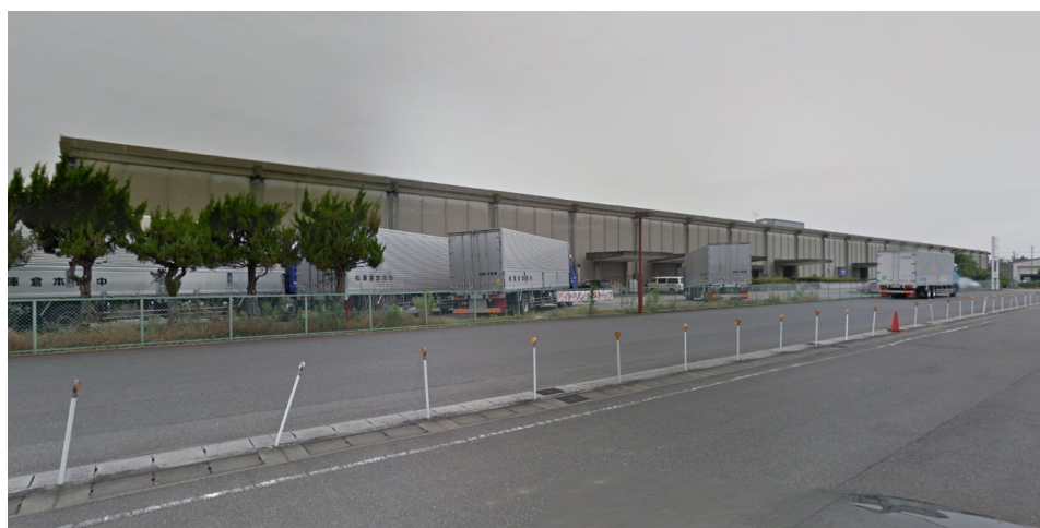
▲ 羽島市に残る「理想の工場」（Google ストリートビューより）
